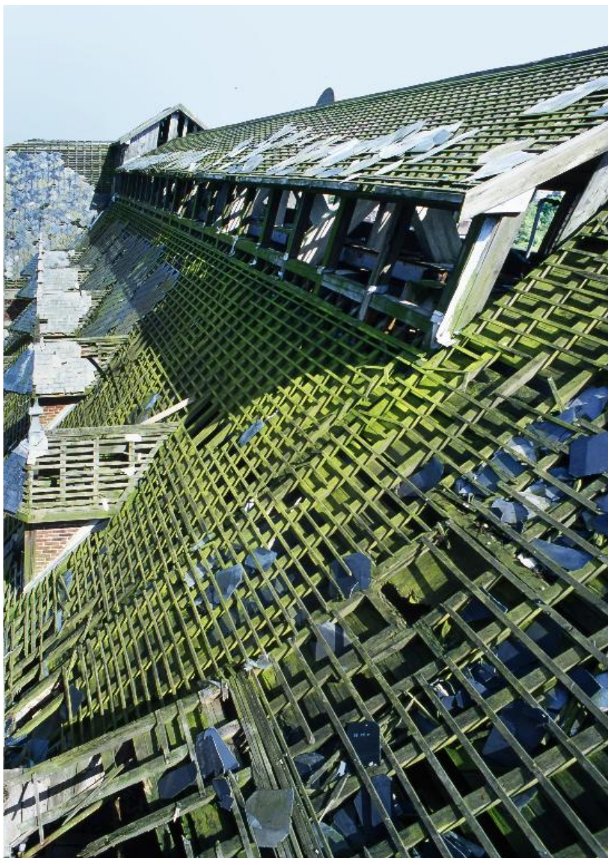
Bâtiment du nettoyage. Charpente, depuis la tour.
