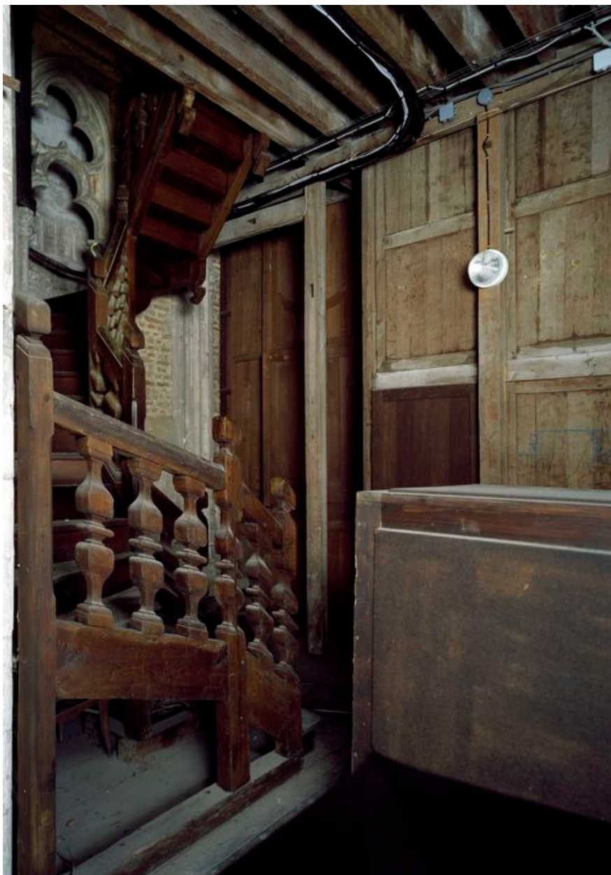
Vue latérale de l'escalier.
