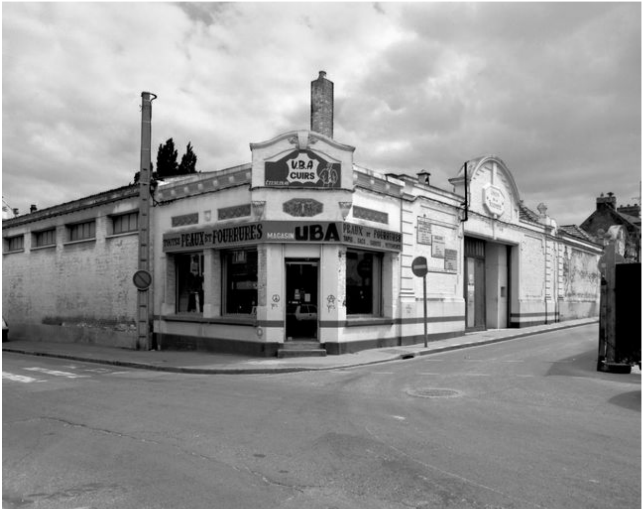
Vue générale, depuis la rue de la Vallée.
