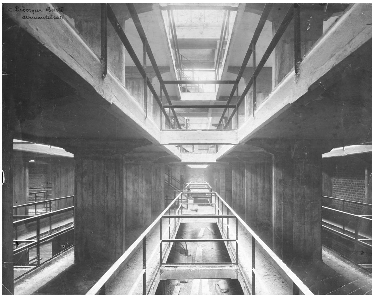
Intérieur du bâtiment du dépôt en chantier : vue du vaisseau 2 depuis le premier étage, côté est. On remarque à droite le mur nord en brique. Photographie (IFA ; 076 lfa 108/10 : 2-C-048).
