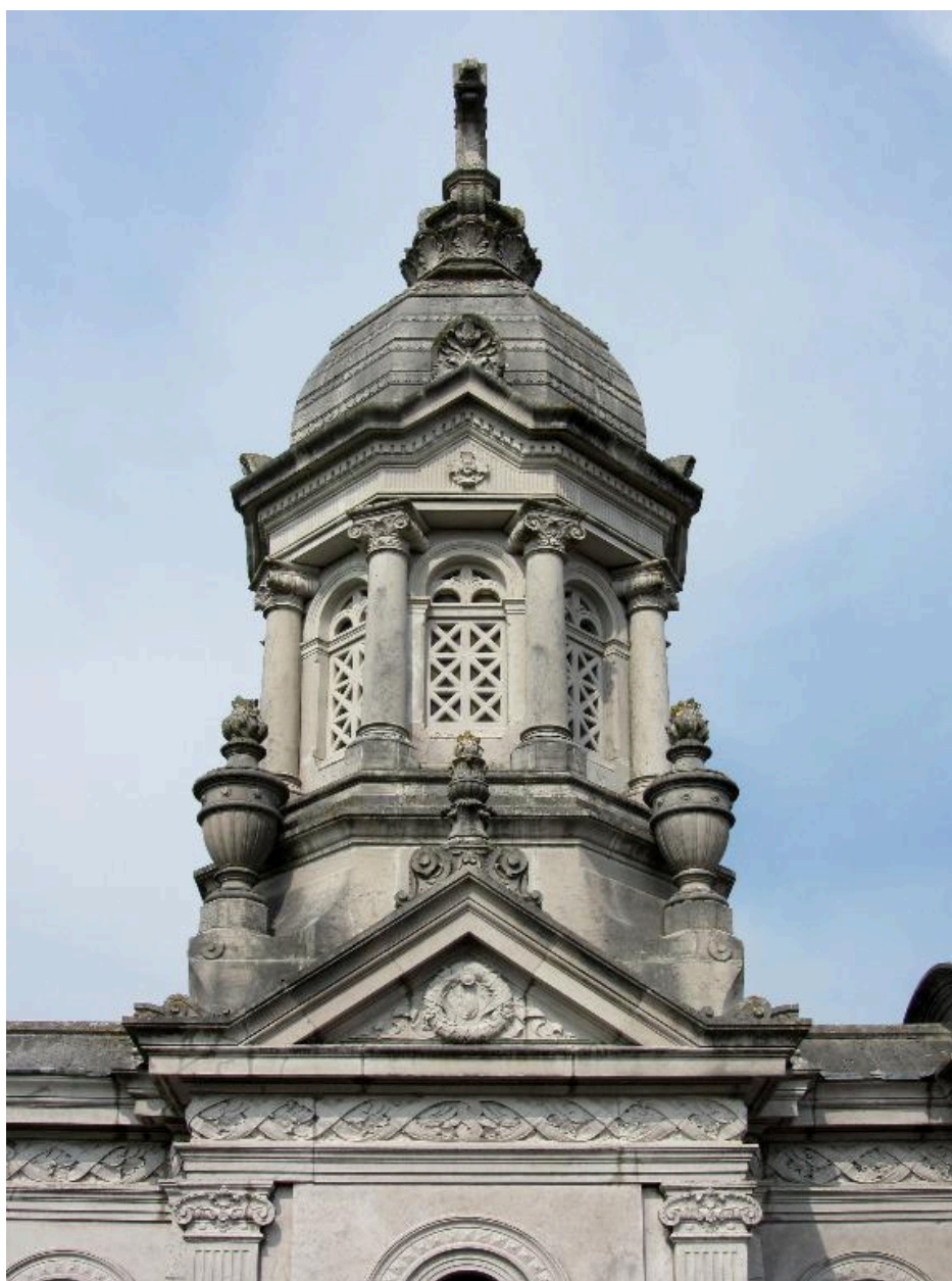
Détail du lanternon.
