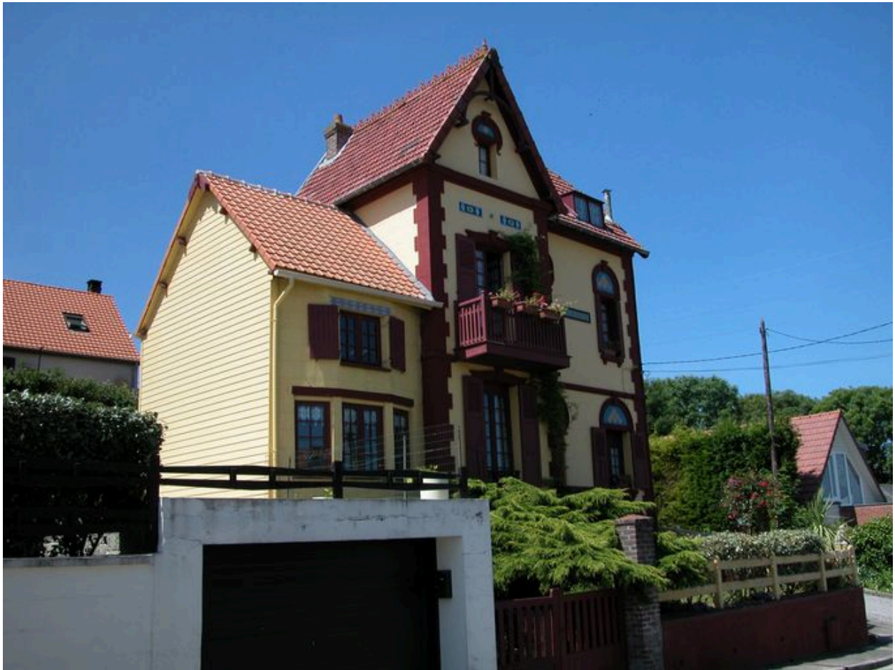
La noue et le pignon en façade, maison dite La Sirène.
