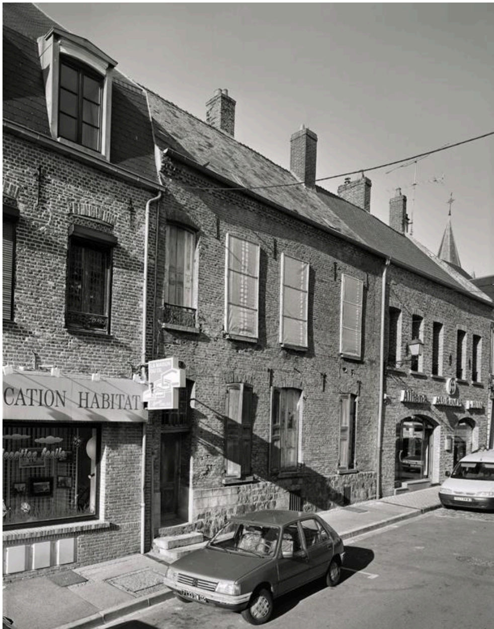
Vue de la façade sur rue.
