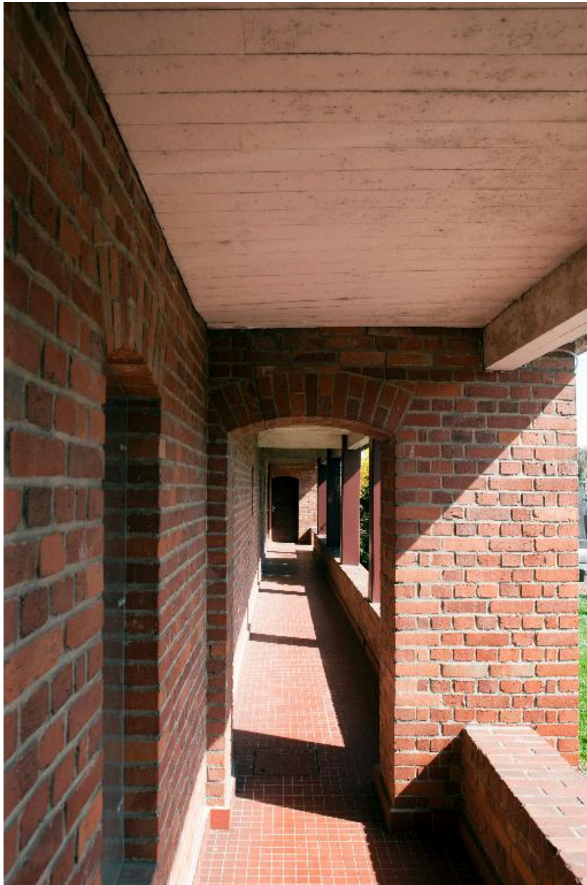
Détail du passage couvert bordant l'édifice.
