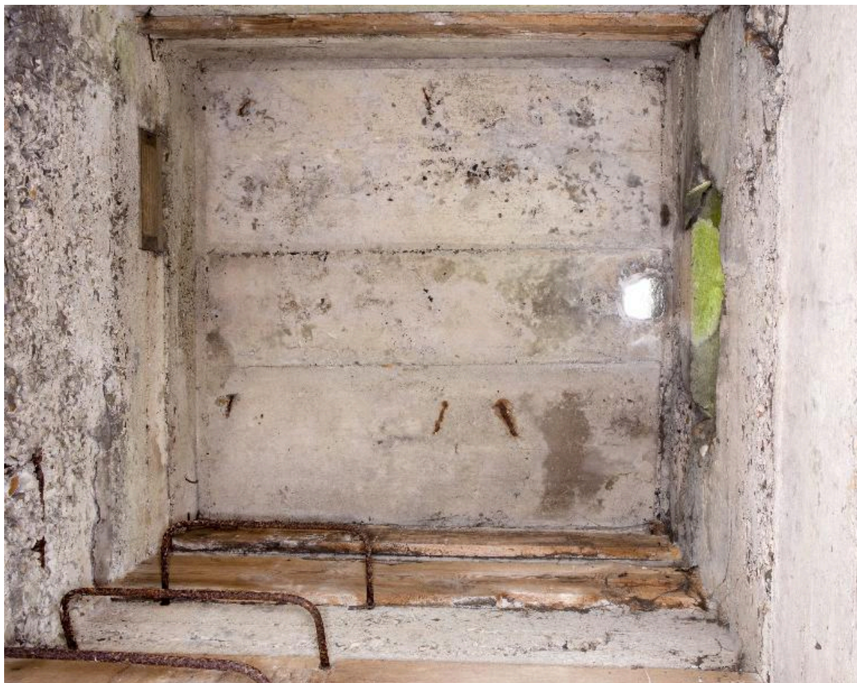
Vue intérieure zénithale
