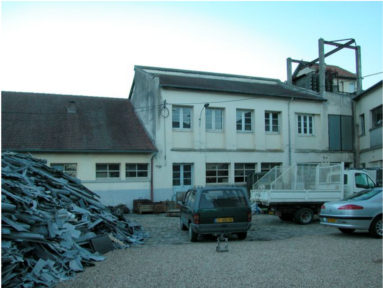
Façade est des bâtiments de la laiterie.
