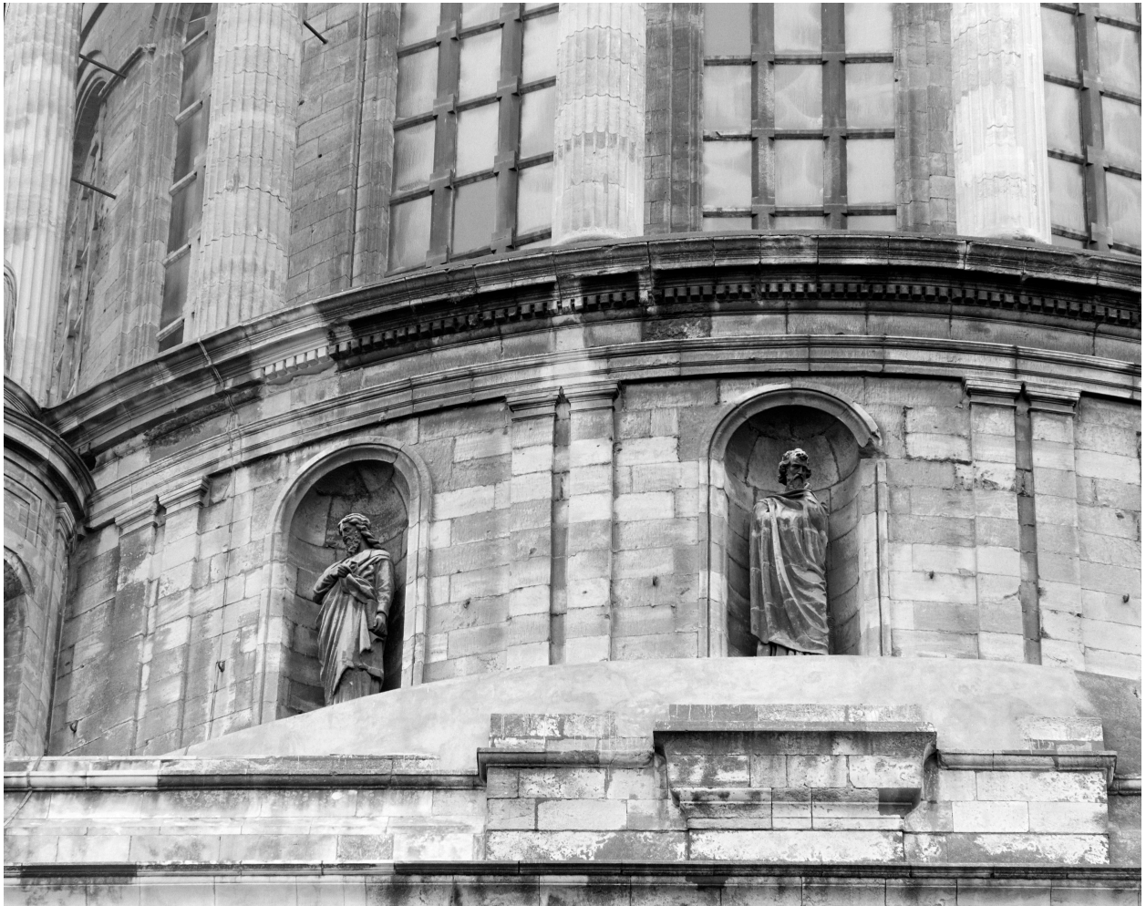
Côté sud, apôtres 2, 3 : vue d'ensemble.
