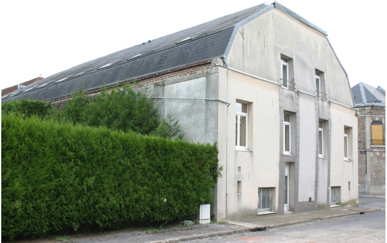
Pignon ouest des anciens ateliers et magasins, rue de Crimée.
