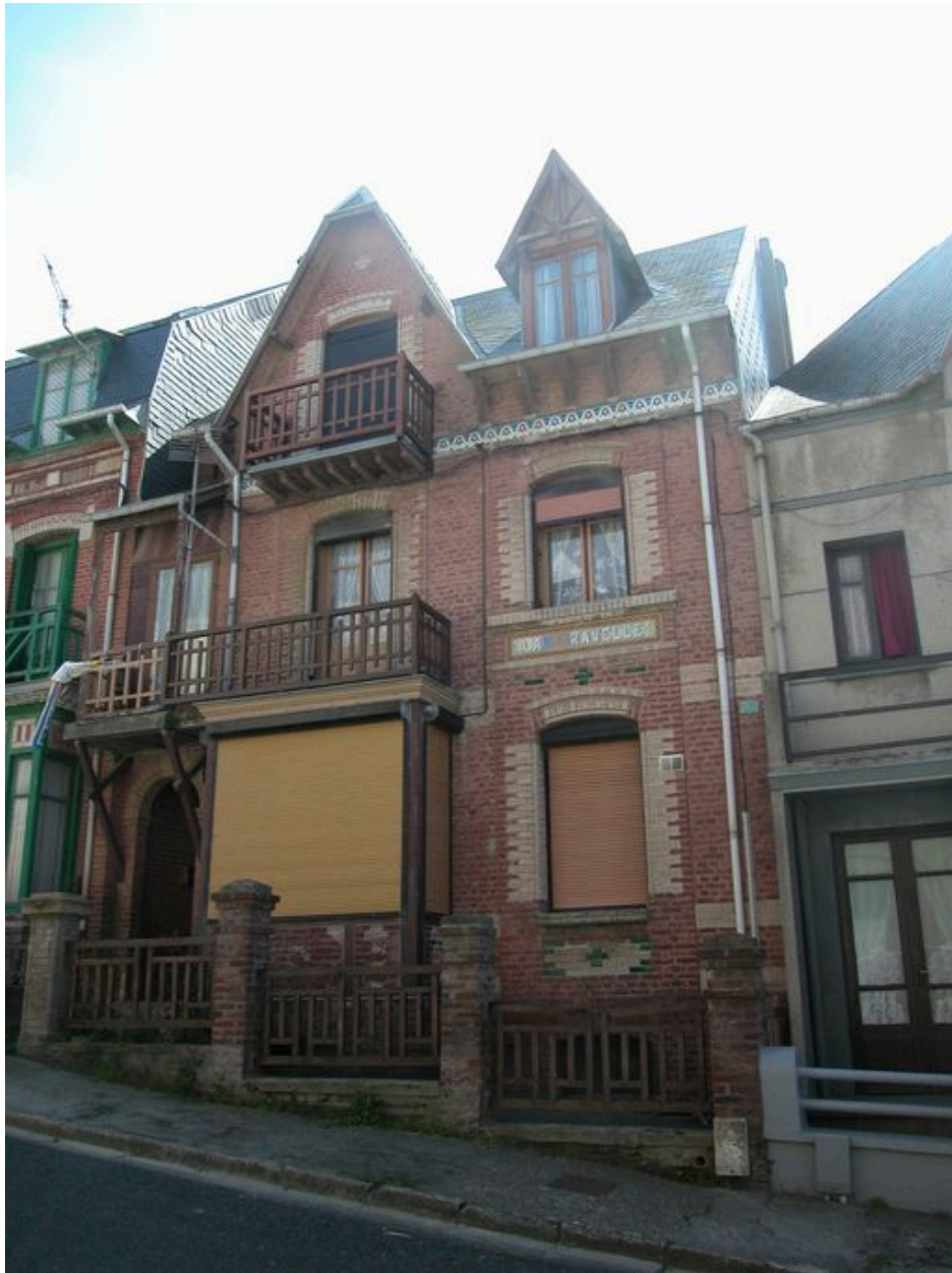
Vue d'ensemble depuis la rue.
