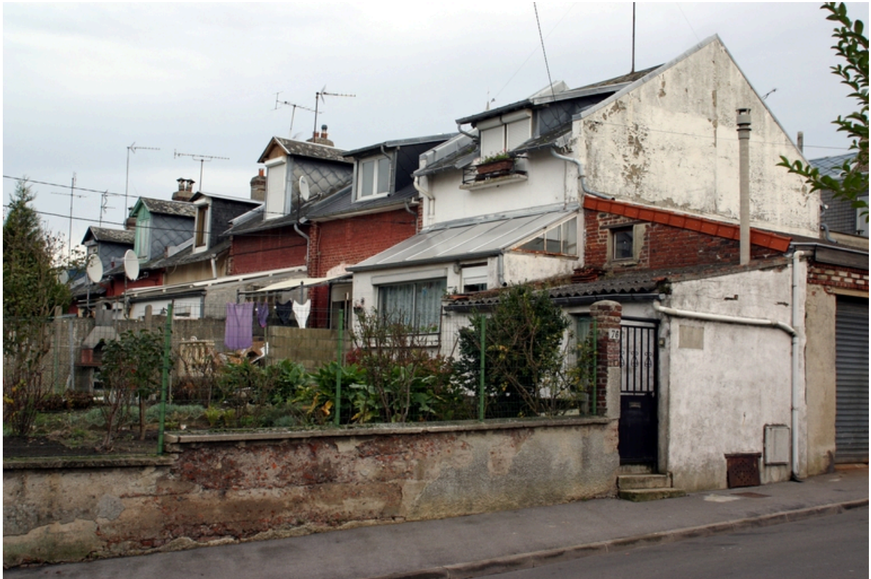
Logements vus depuis la rue de Flandre.
