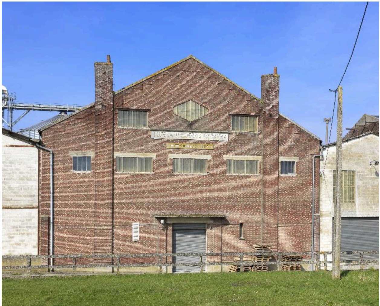
Pignon du bâtiment prolongeant l'atelier principal.
