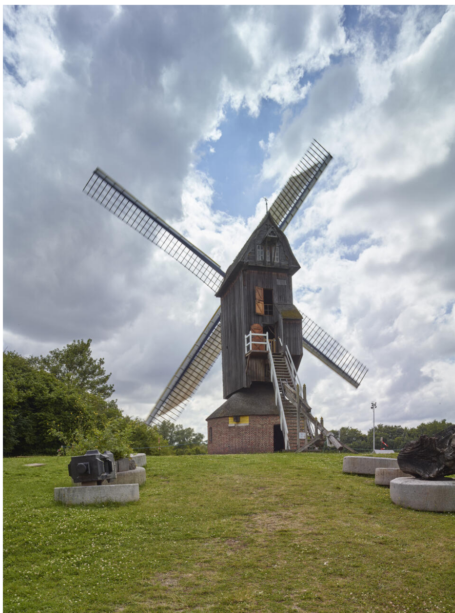
Vue générale prise depuis l'est.
