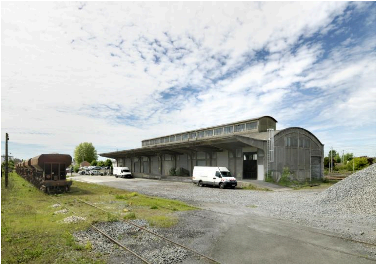
Halle de marchandises de type 2bis à 10 portes. Vue depuis le nord-est.
