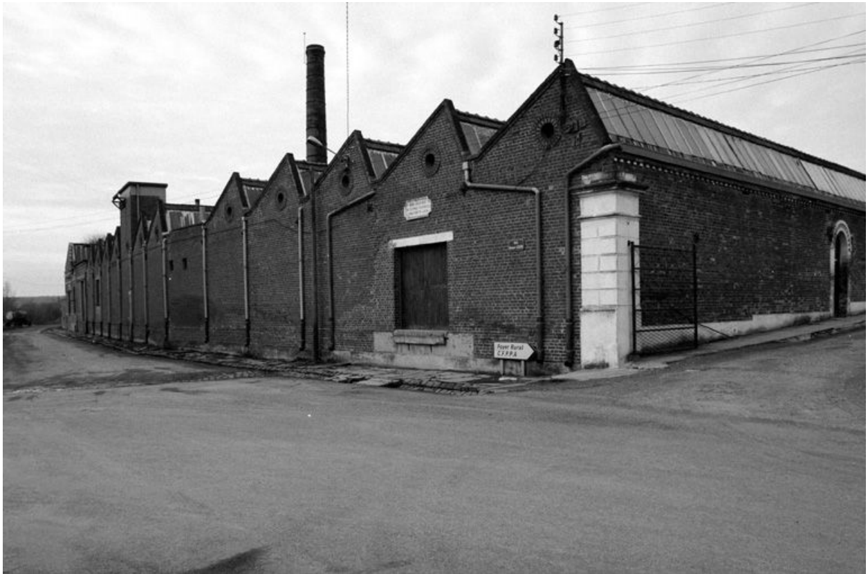
Atelier de fabrication, vue partielle, flanc sud.
