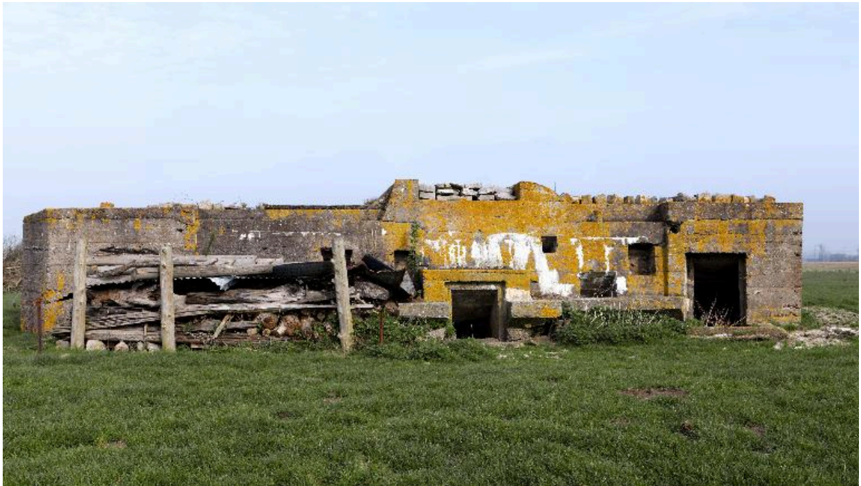
Elévation sud, vers le nord
