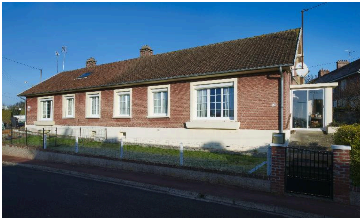
Maison à deux unités d'habitation, rue Bellevue.
