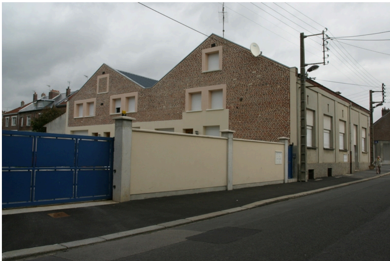
Façade postérieure des ateliers (pignons sud-ouest).
