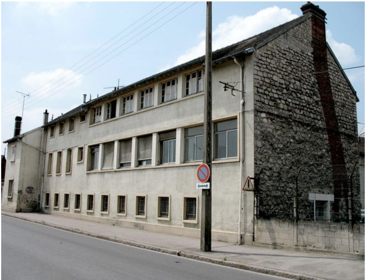
Le bâtiment abritant la conciergerie, les vestiaires et le refectoire de l'usine.
