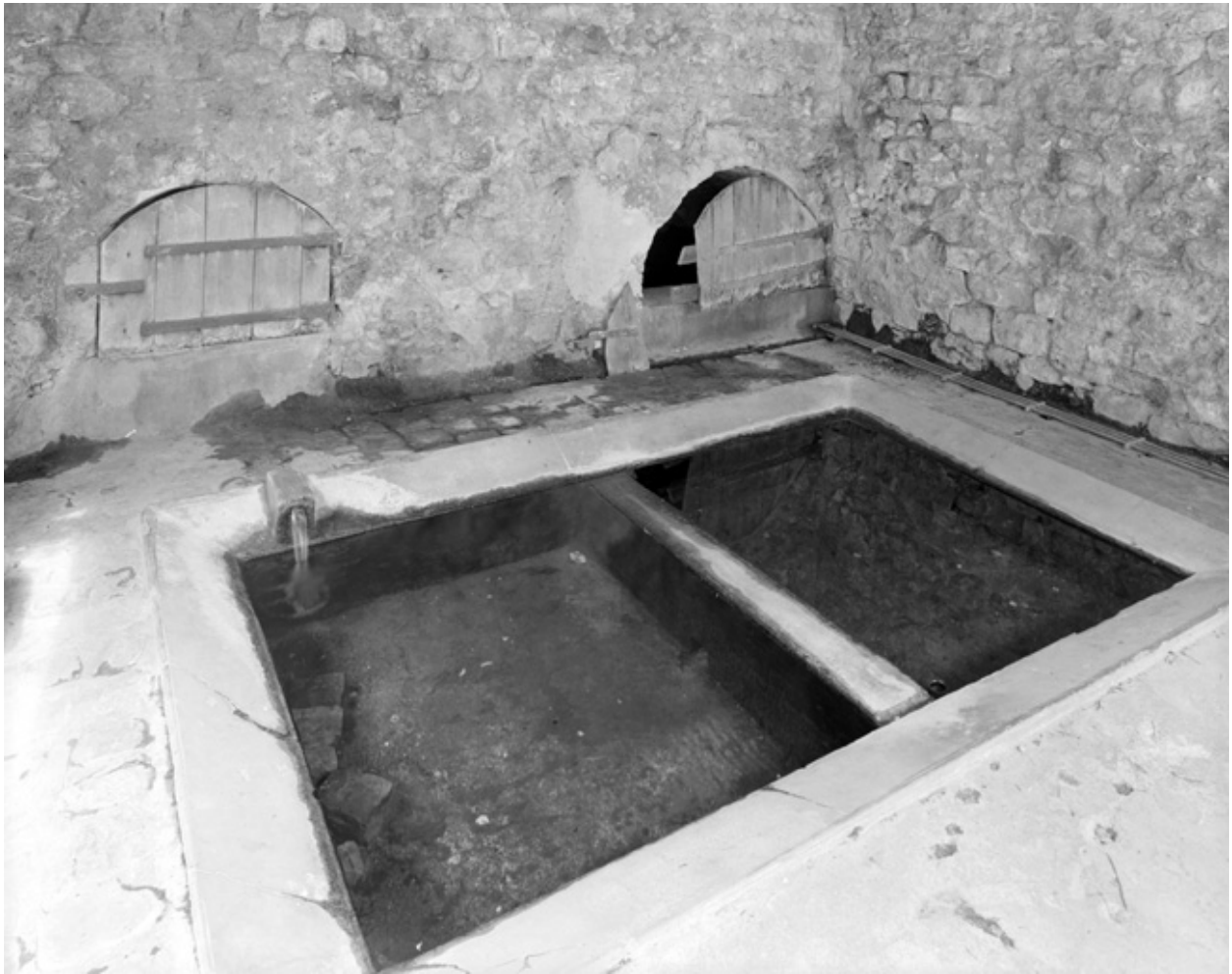
Rue de Bue. Lavoir : vue du bassin et des portes des réservoirs ou conduits d'arrivée d'eau.
