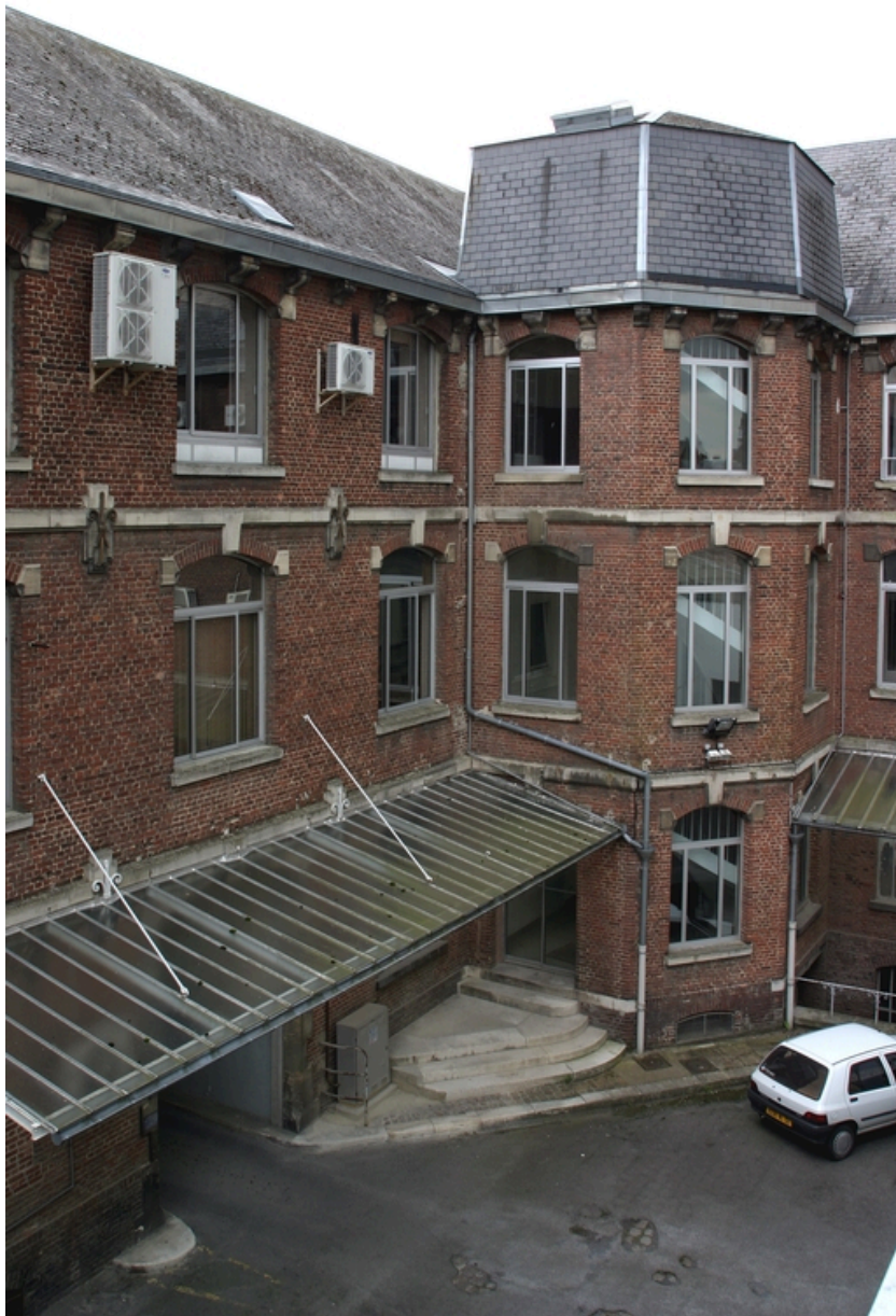
Façade postérieure de la maison de commerce : porche d'entrée et tour d'escalier.
