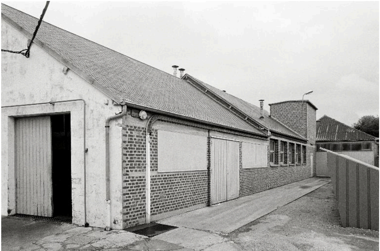
Atelier de fabrication (1946), vue partielle en 1990.
