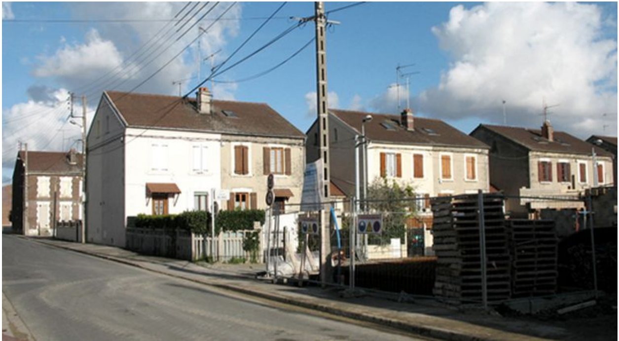
Vue générale des deux bandes de maisons constituant la cité ouvrière Louis Blanc
