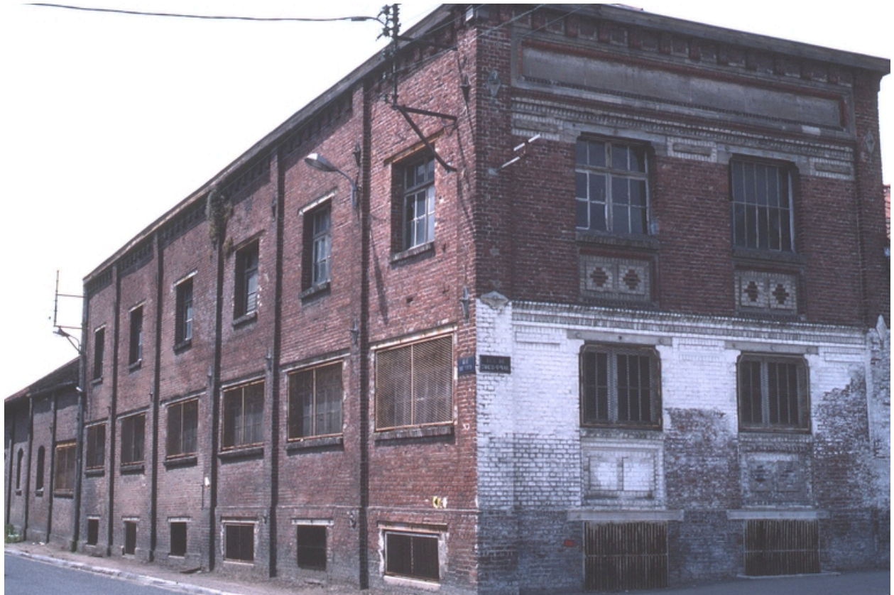
Anciens ateliers de bobinage et de retorderie, à l'angle des rues de Tour-Y-Val et de Vicq, 1983 (BM Saint-Quentin).
