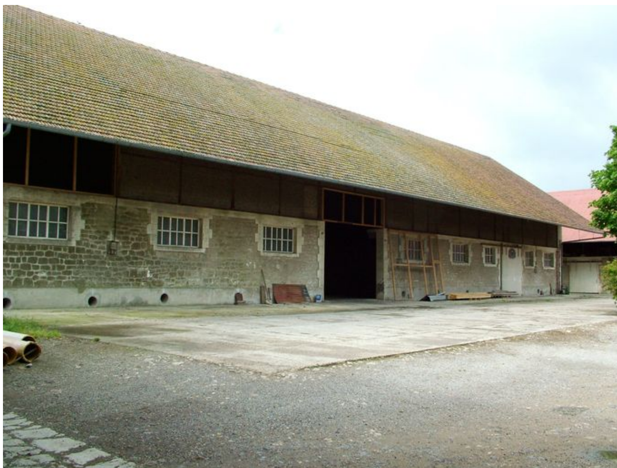
Vue d'un bâtiment agricole.
