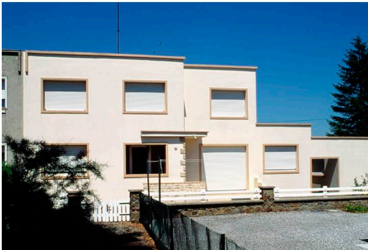
Vue générale d'un logement, n° 84.
