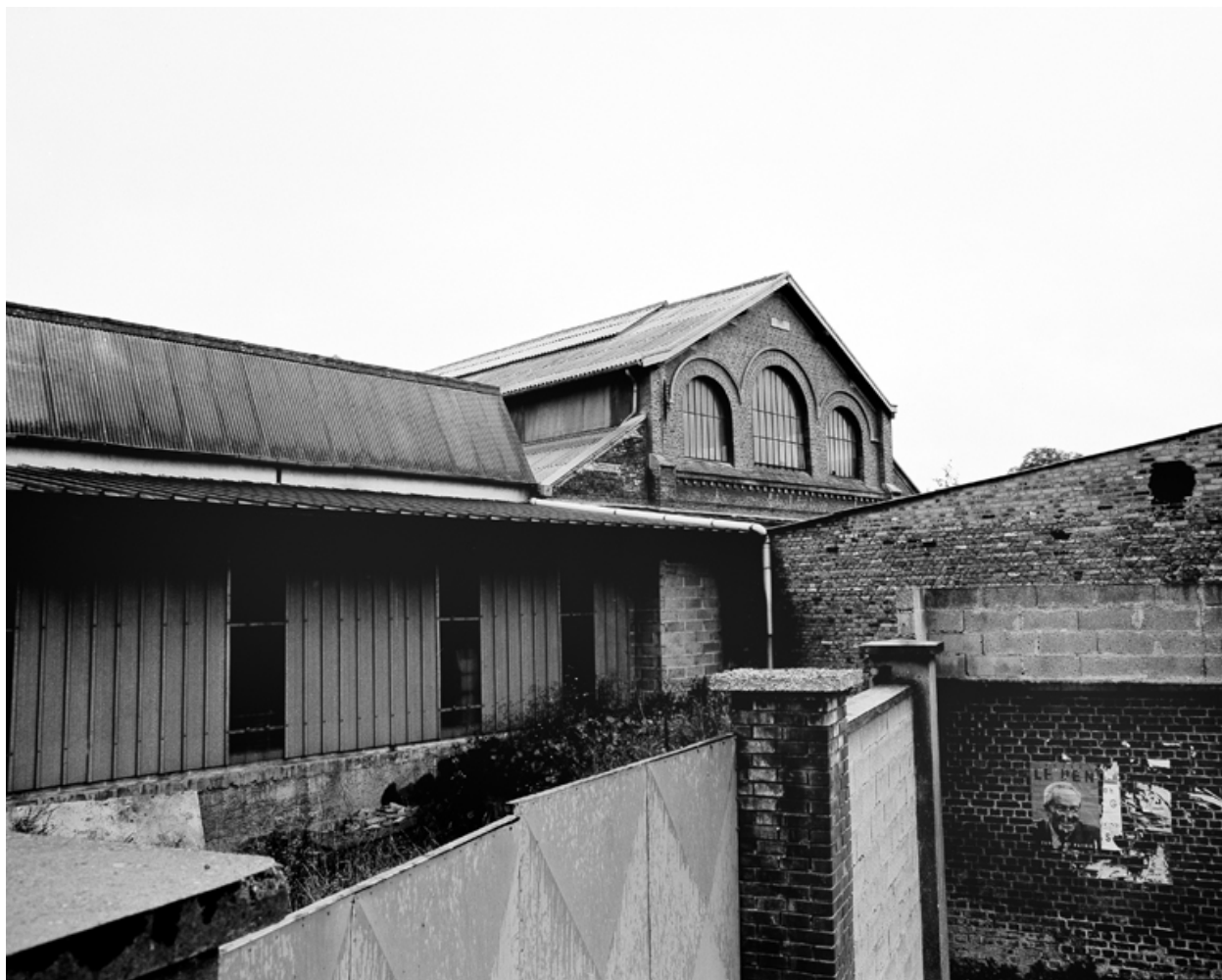
Atelier de fabrication, vue partielle.
