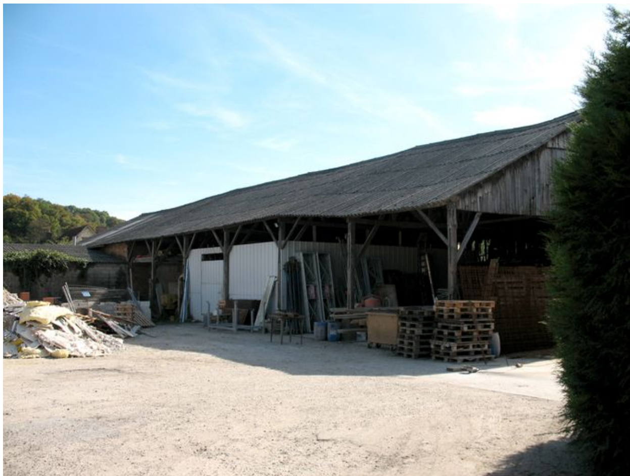
Hangar en bois construit pour le stock des fûts.
