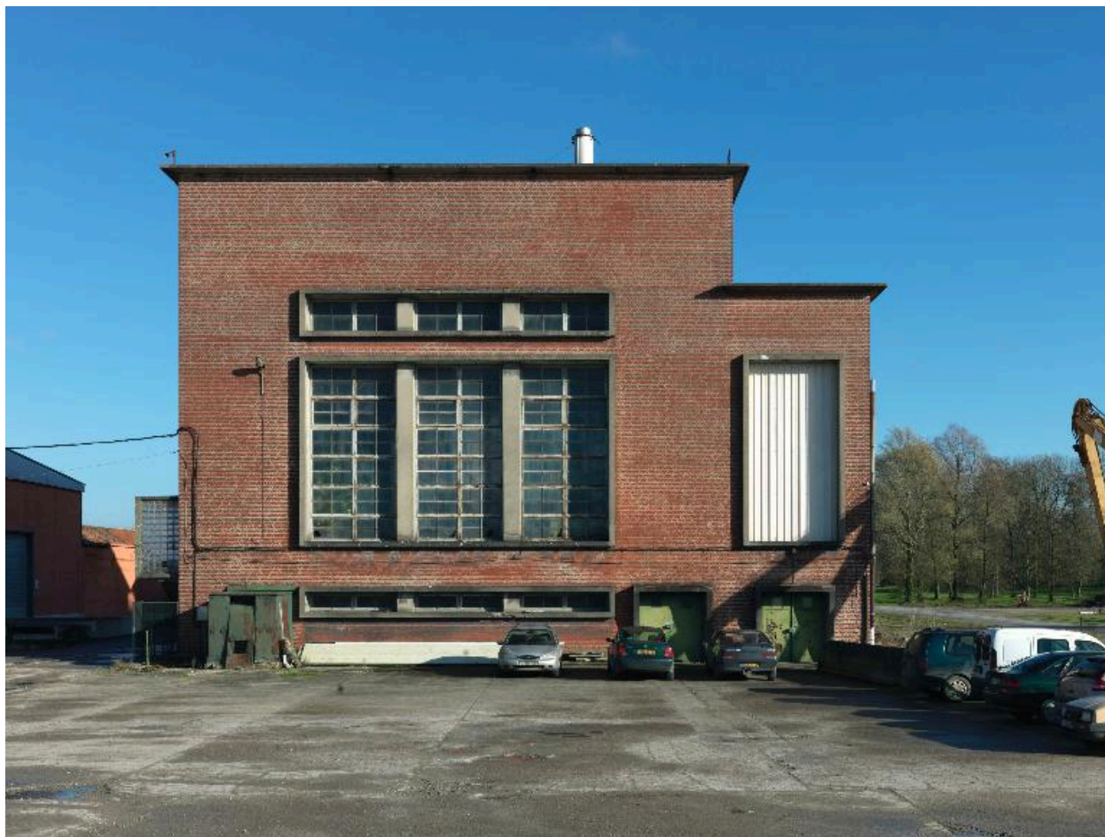
Façade ouest de la chaufferie à charbon, précédé de l'ancien parc à charbon.
