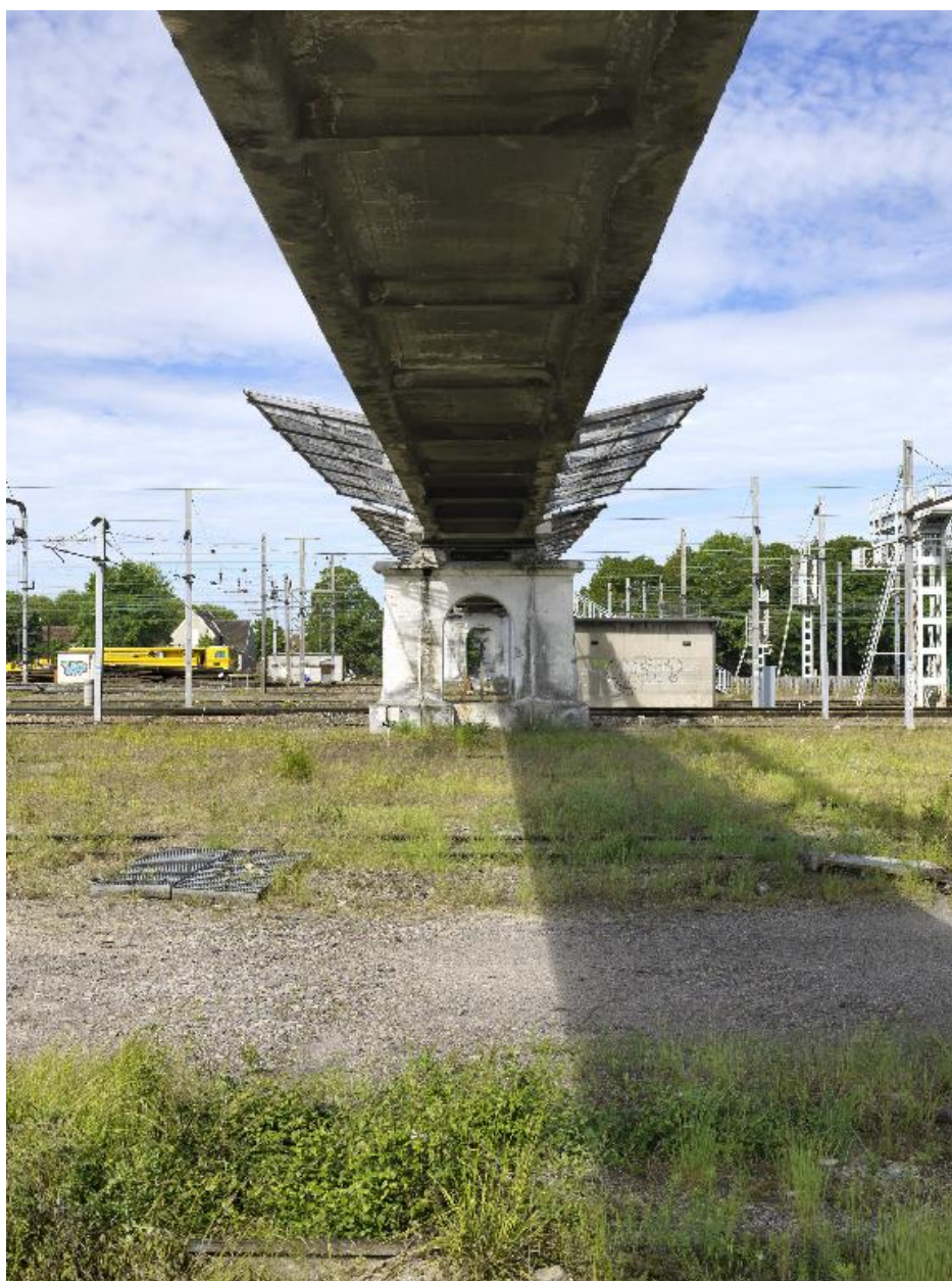
Dessous du tablier de la passerelle.
