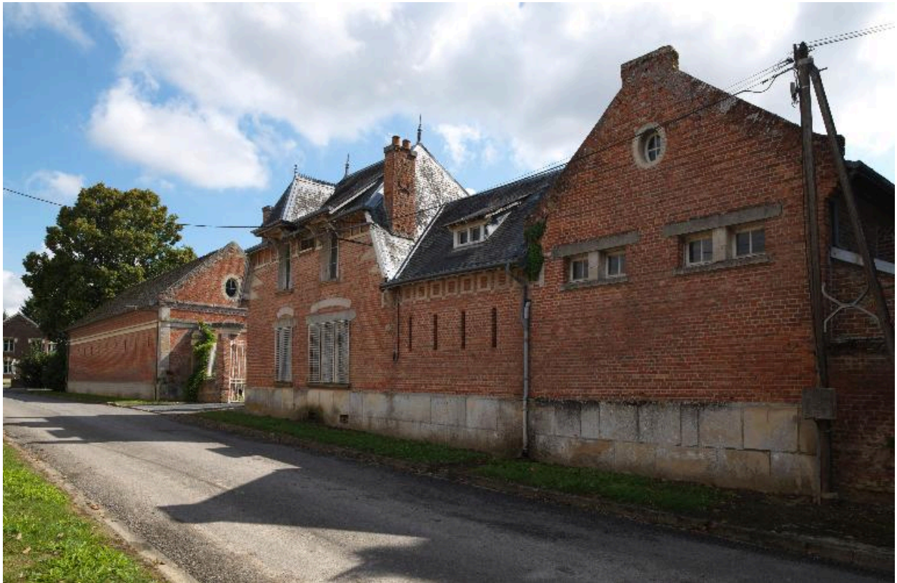
Vue de situation, depuis la rue.
