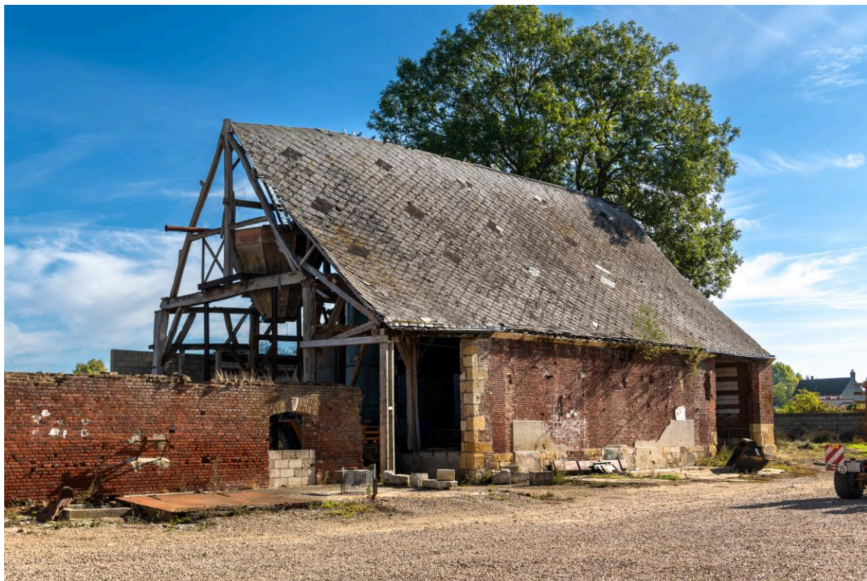
Ancienne grange, vue depuis l'ouest.
