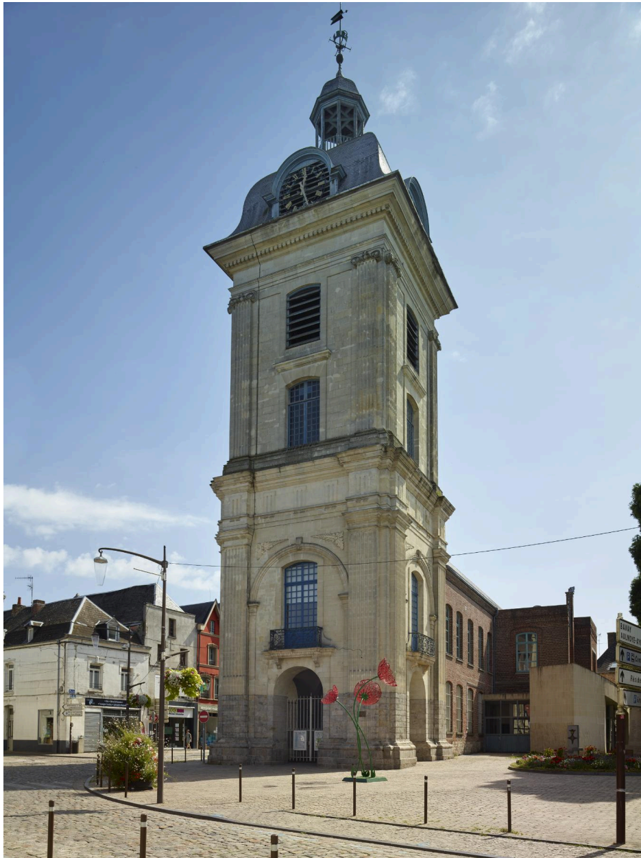
Beffroi : façade sud.
