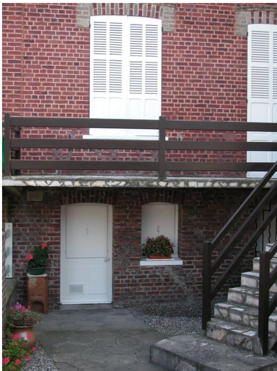
Détail du soubassement habitable.
