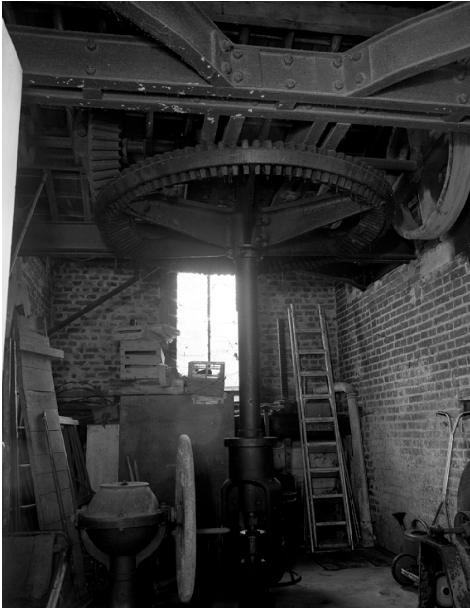
La turbine hydraulique installée en 1896.
