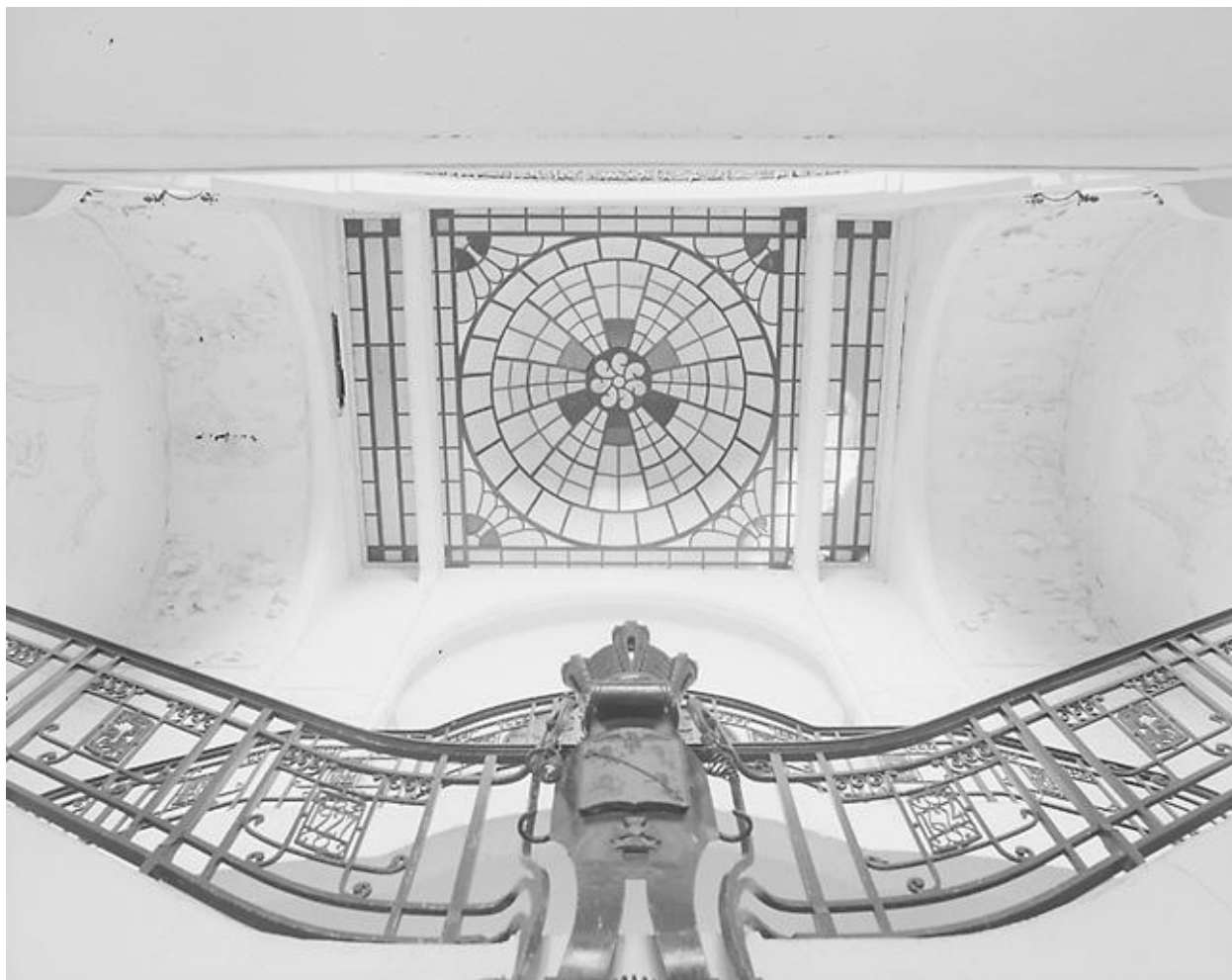
Rampe d'escalier et coupole vitrée (obturée en 2001).
