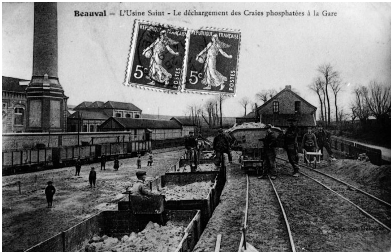
Déchargement de craies phosphatées en gare de Beauval vers 1900 (AD Oise ; fonds Ecomusée du Beauvaisis).
