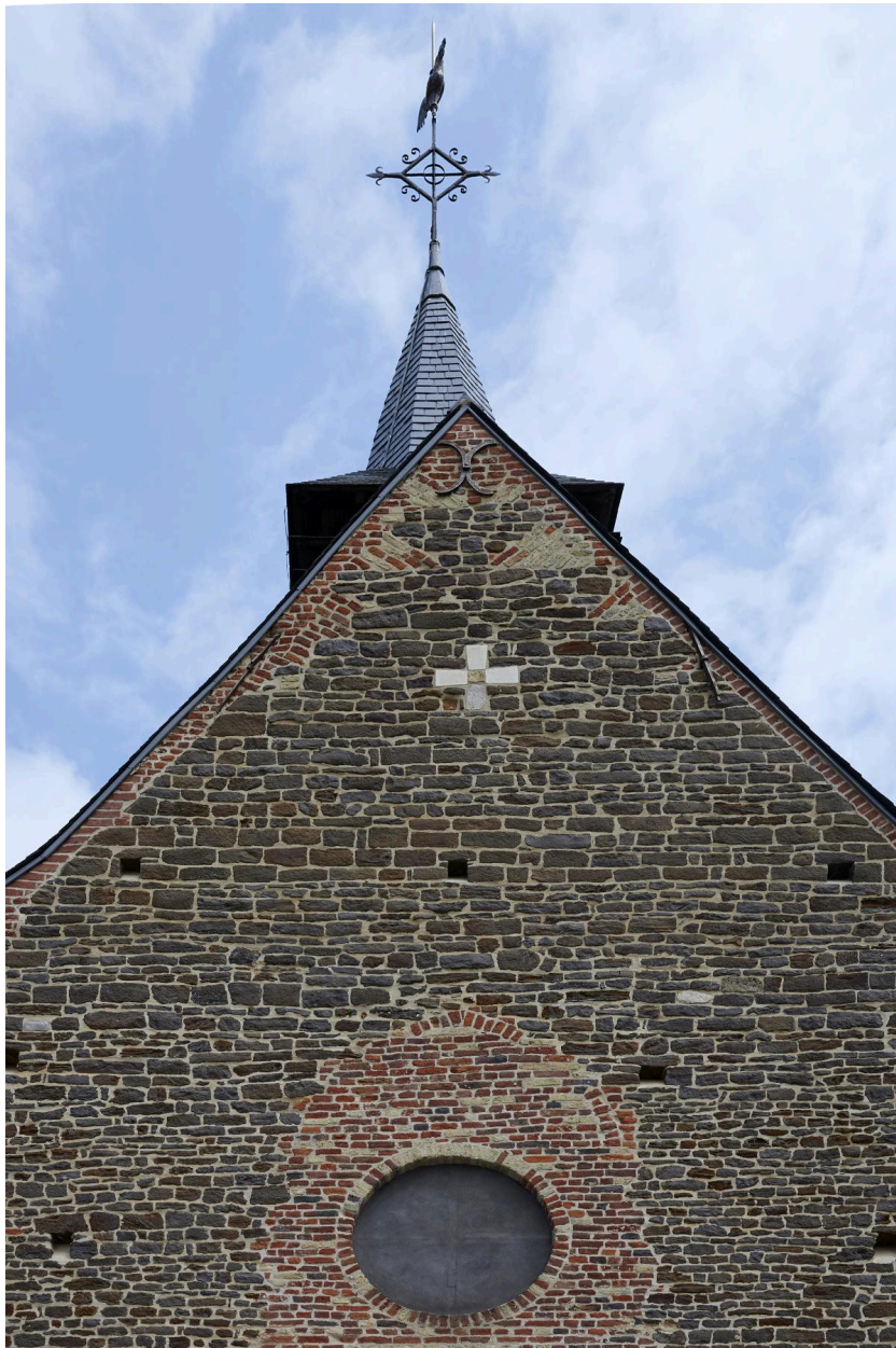
Détail du pignon de la façade principale (ouest).
