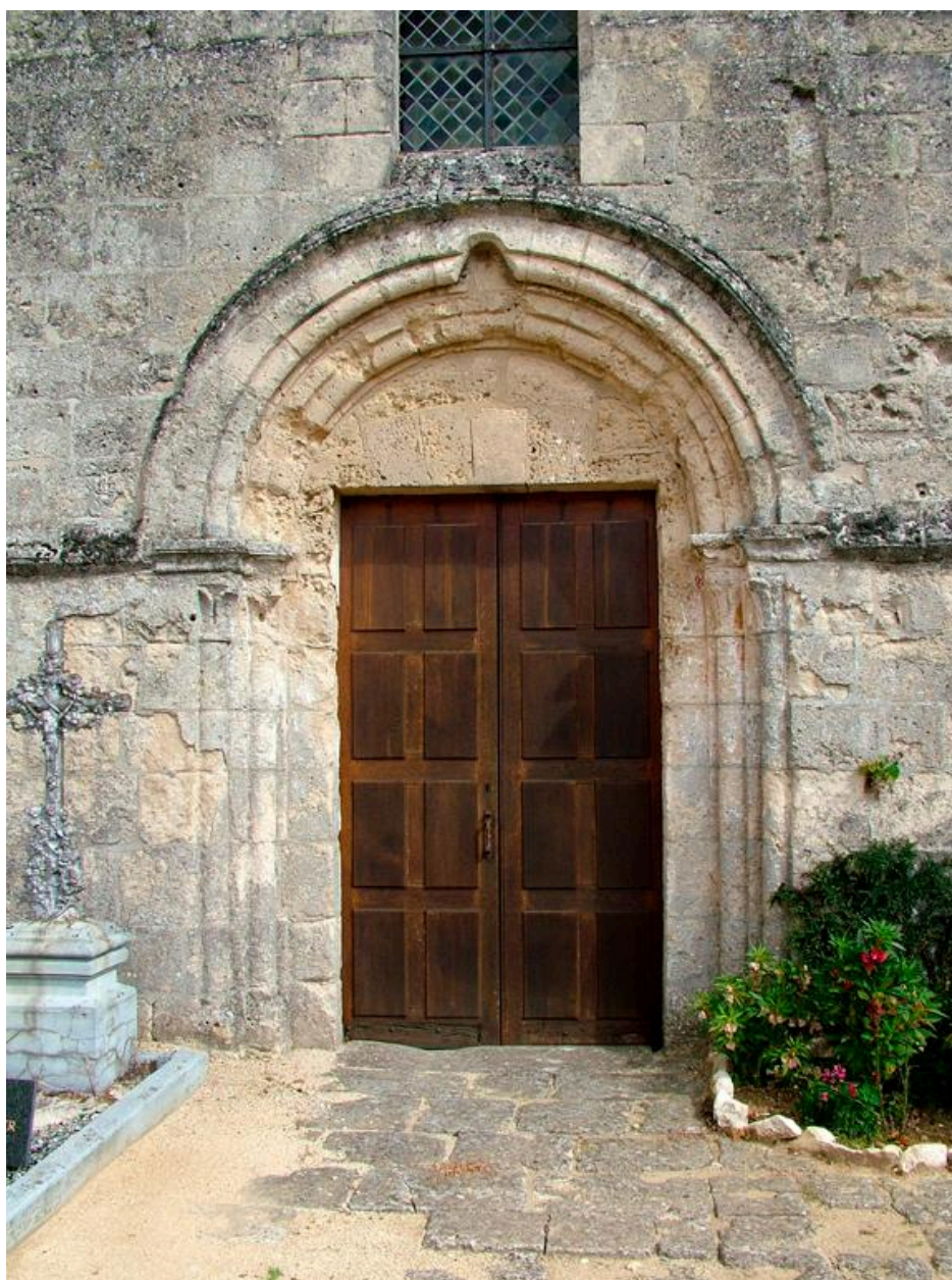
Vue du portail occidental.
