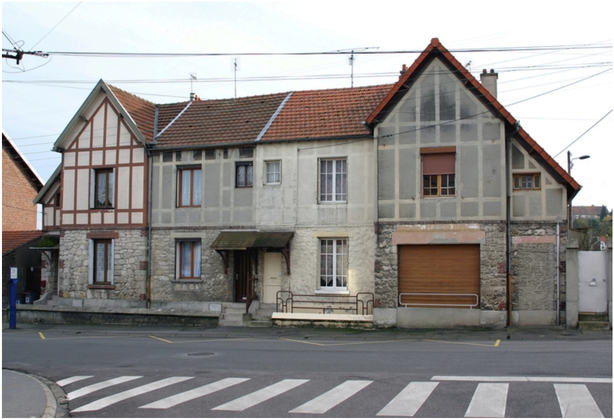
Groupe de 4 logements, rue du Docteur Cordier.
