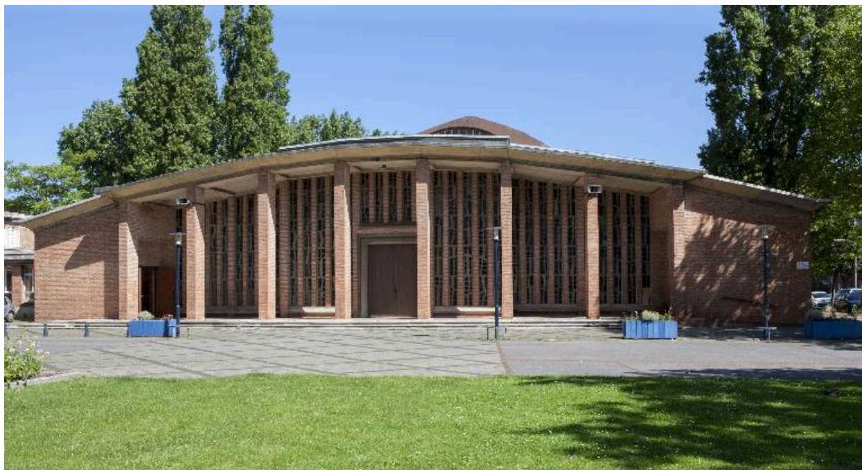
Élévation antérieure de l'église.
