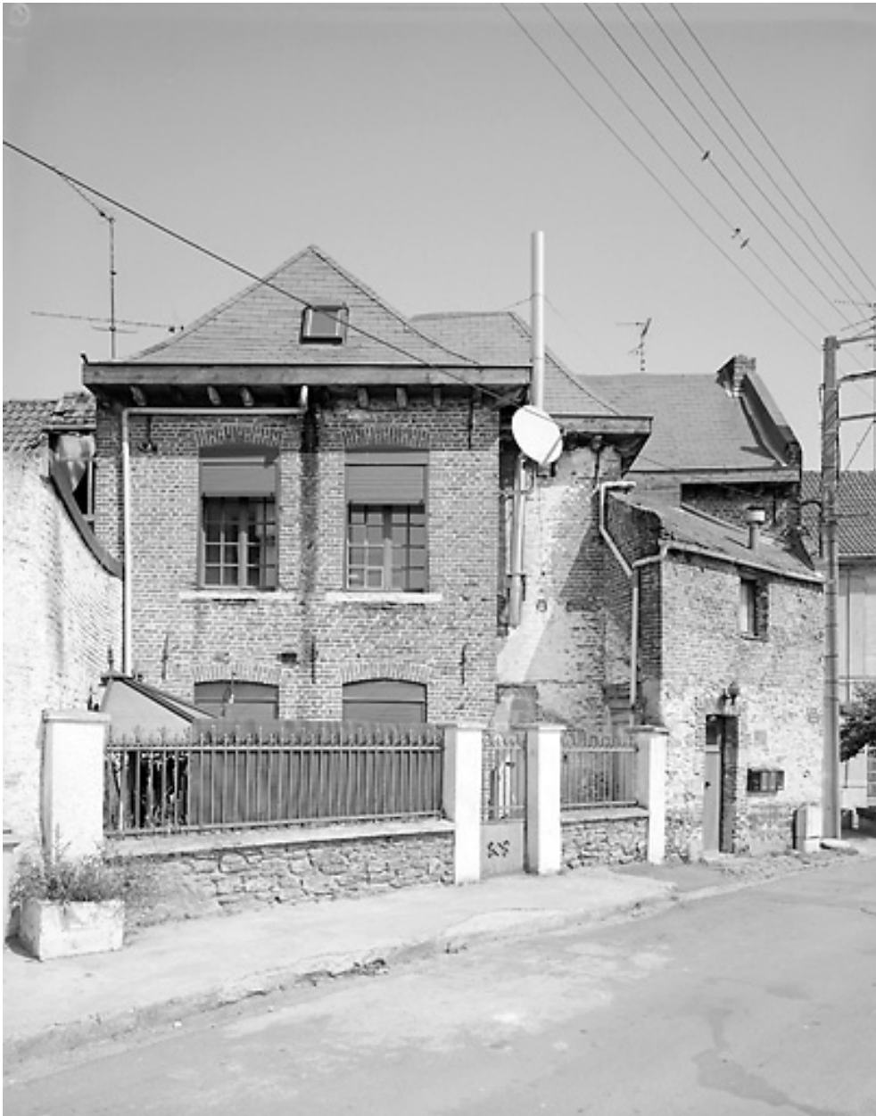
Vue générale des façades arrière (état en 2001).
