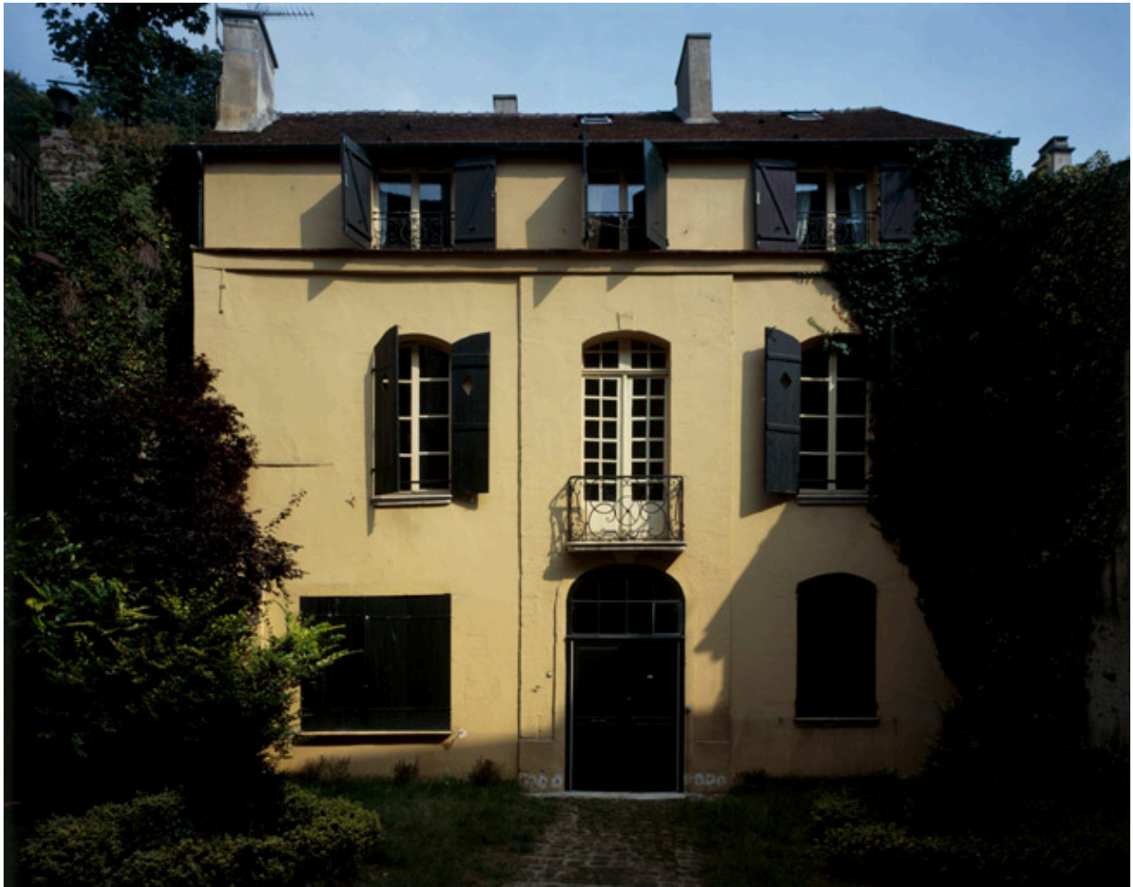
Le bâtiment en fond de cour.
