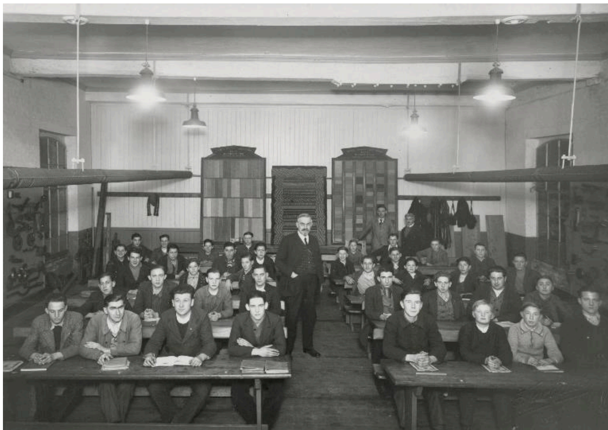
Salle de formation continue pour les ouvriers de l'usine, 1937.
