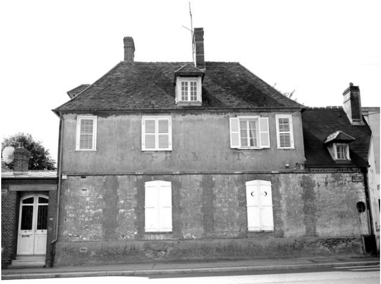
Façade sur rue du logement et du bureau de l'usine.
