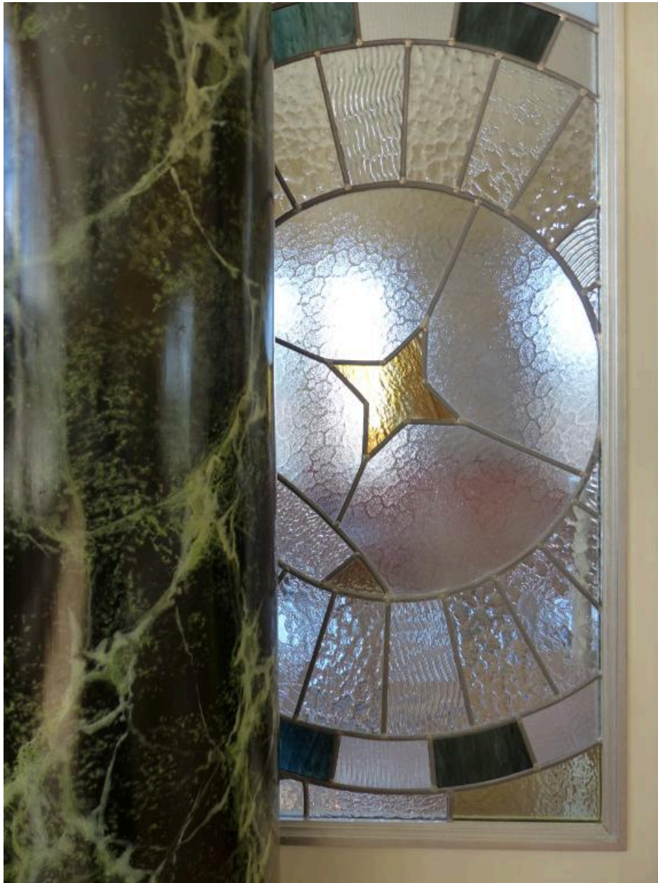
Colonne (peint faux-marbre) et détail de la verrière.
