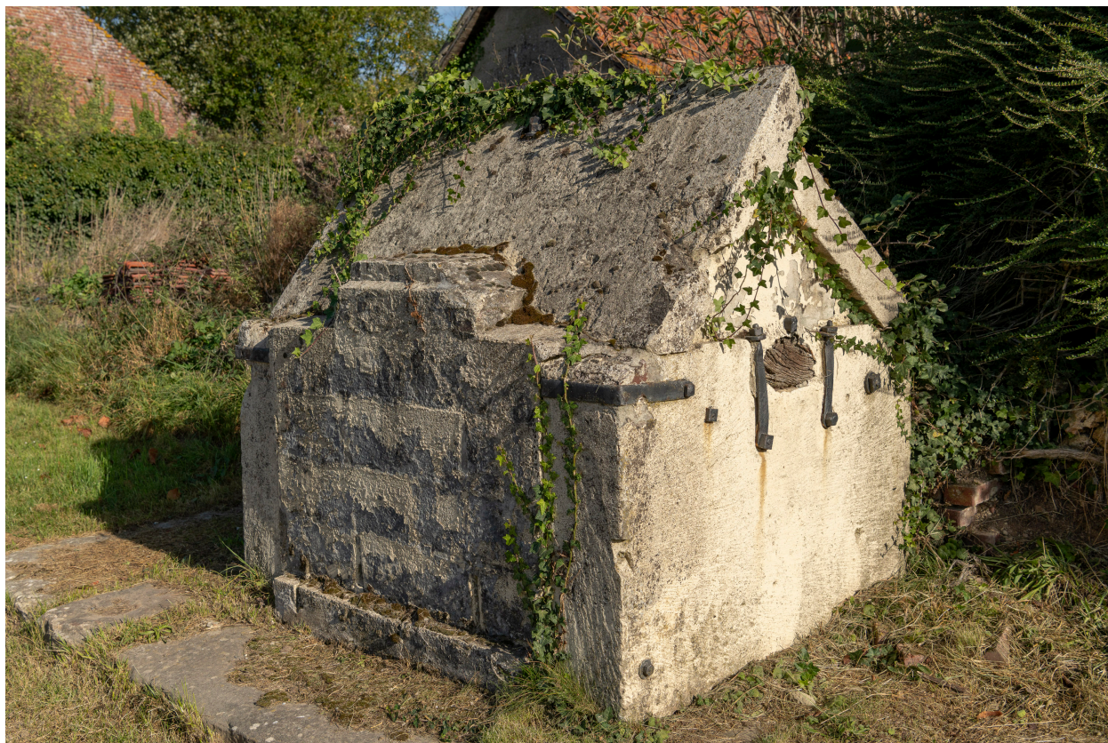
Ancien puits, rue de Sérévillers, vue prise depuis le sud-ouest.
